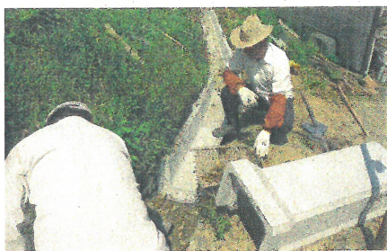
水路メンテナンスの様子
